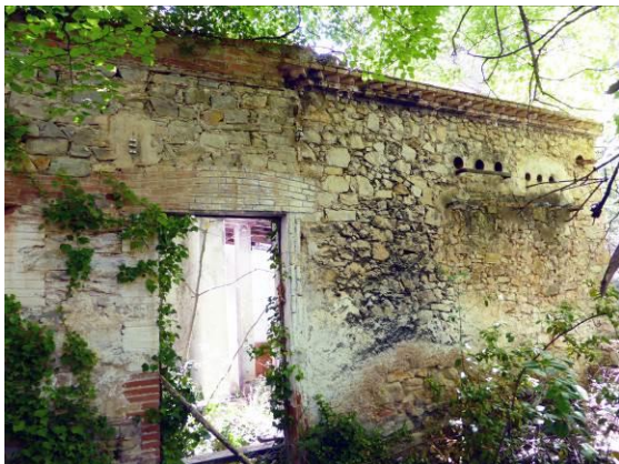
Vista general de l'estat actual del conjunt de l'antiga central elèctrica.
